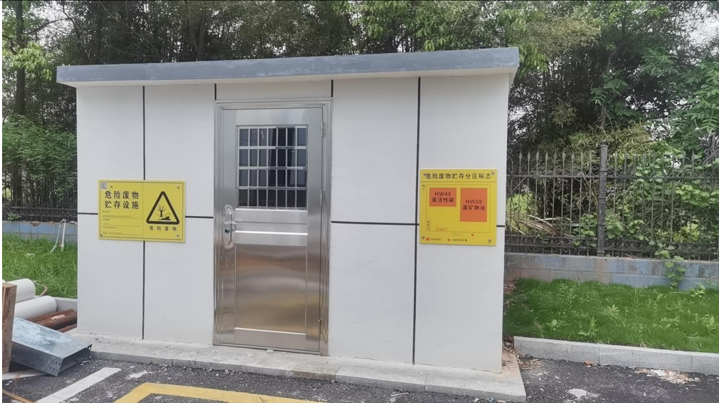
危废暂存间照片
