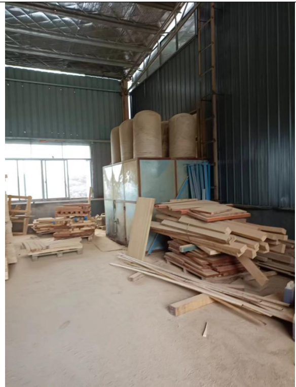
7号厂房布袋除尘器6 (TA021)
