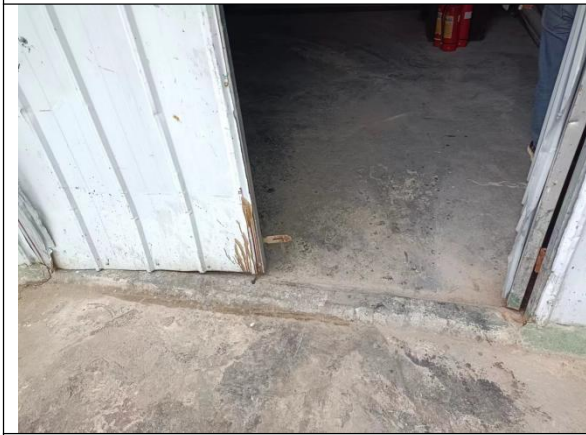
危废暂存间门口围堰
