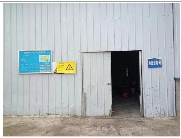
危废暂存间门口标示标牌
