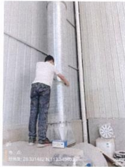
有组织废气处理后排气筒 G6
