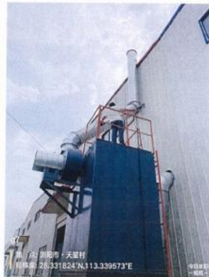
有组织废气处理后排气筒 G7
